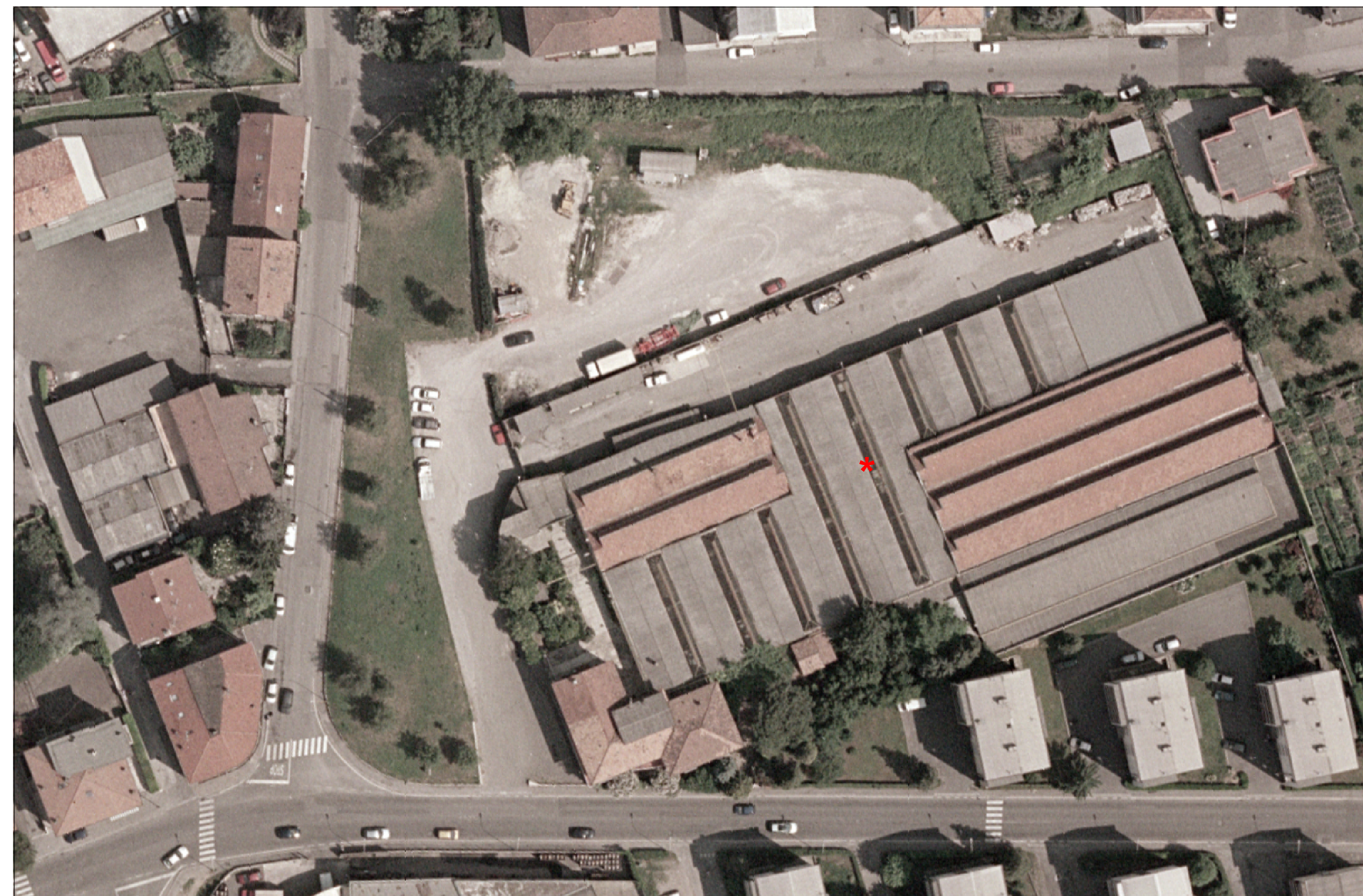
Foto aerea dello stato attuale
